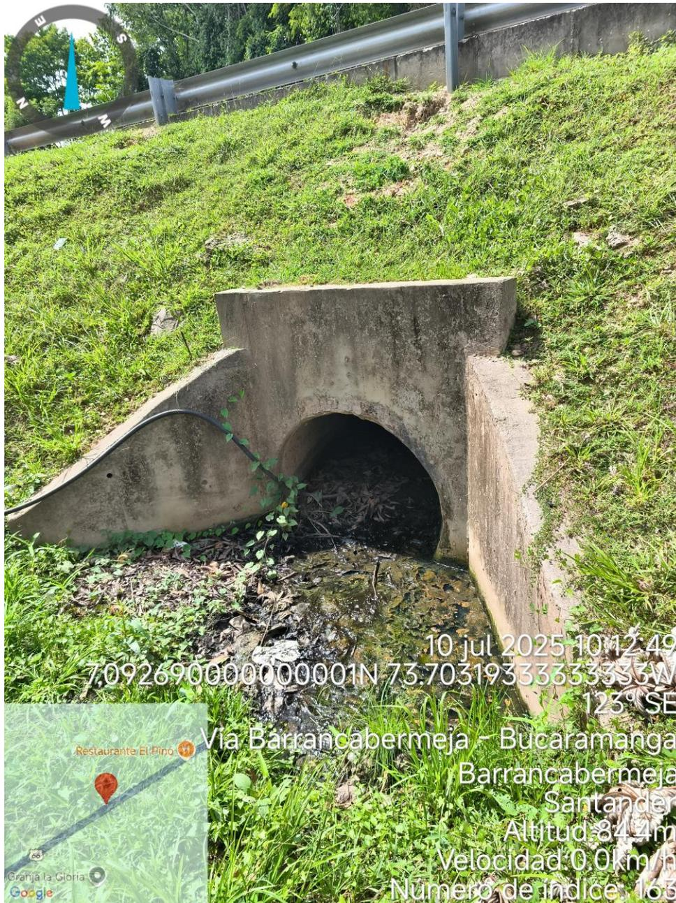
**Figura 41.** Alcantarilla circular al occidente del box monitoreado.
