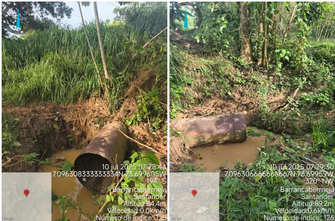
**Figura 31.** Detalle de la Tubería drenaje bajo vía de acceso al relleno sanitario
