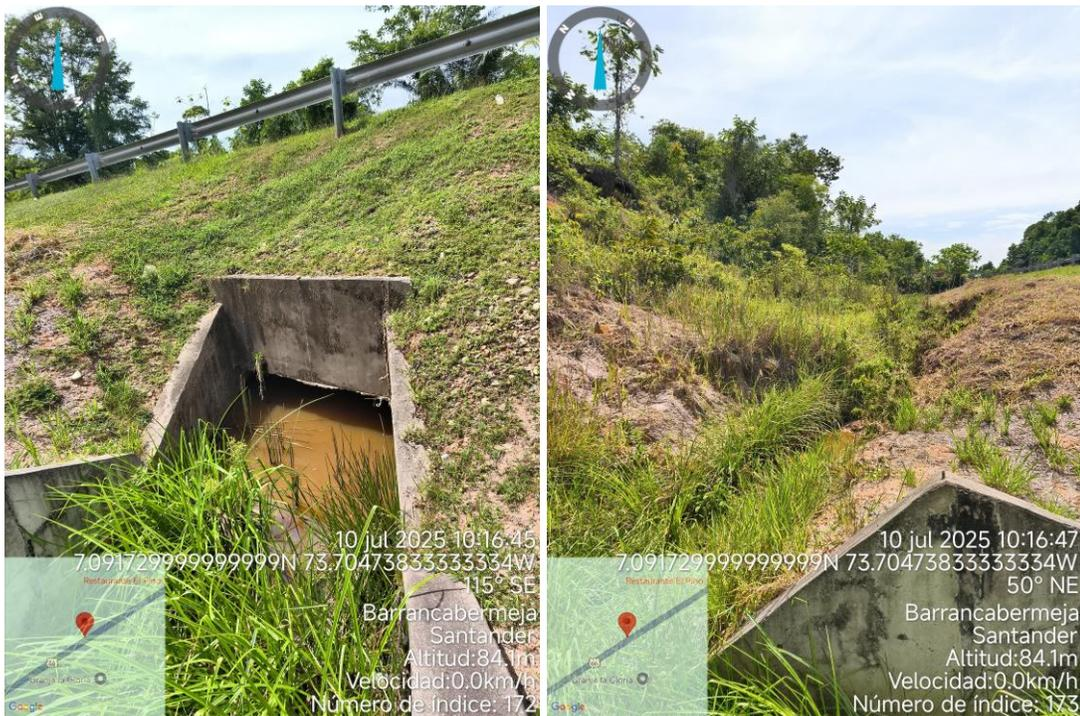
**Figura 42.** Box Culvert con acumulación de caudales.
