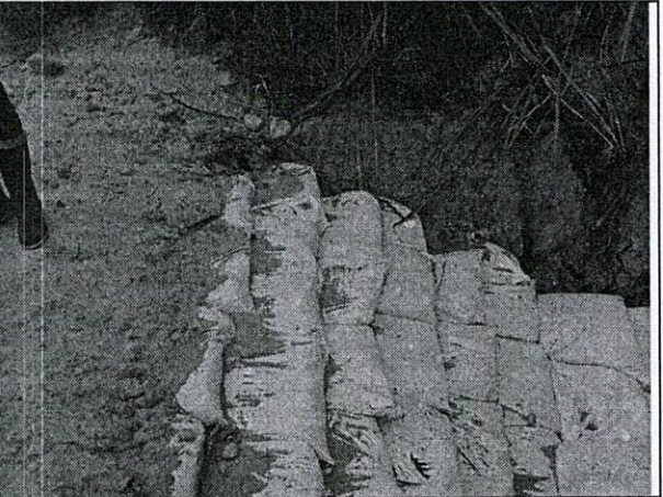
Fotografías 26: obra de descole, escorrentía esquina nor-occidental. Fuente: Equipo Técnico CAS 2025
